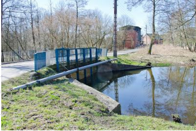
Nr 8 Odbudowa jazu Klawek
